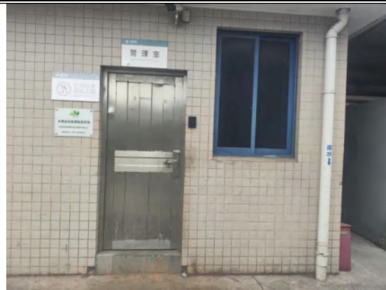
废水在线监控
